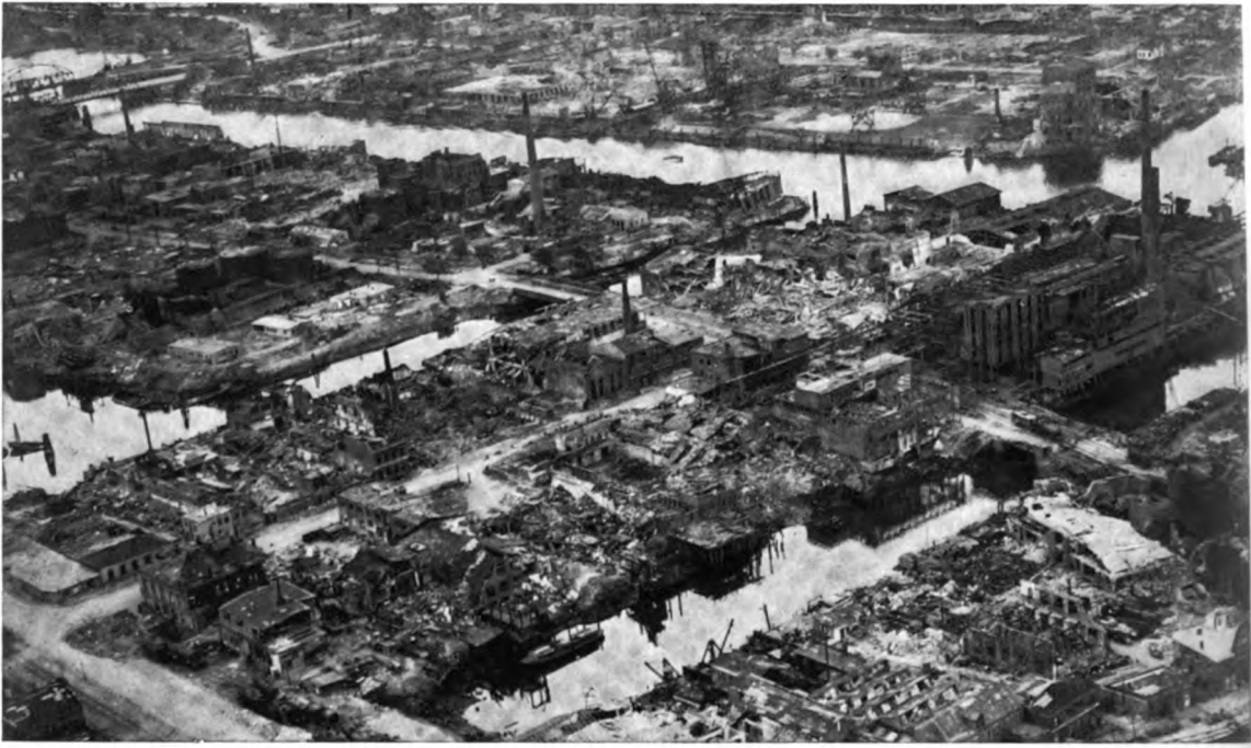
30. Hamburg—bombed dock area
